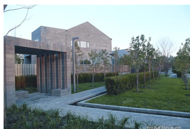
北京-运河上的院子 （混凝土-砖石结构）
